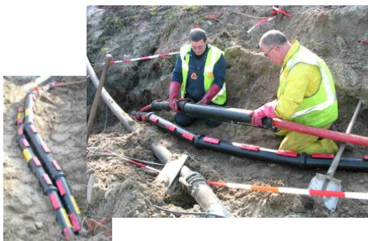
Sehr langlebige Qualität, **halogenfrei**, **langfristig UV-beständig**, für offene und Künettenverlegung! extreme Scheiteldruckfestigkeit **750N** (281929 450N) und Ringsteifigkeit **SN8(4,12)** nach EN ISO 9969 (außer 281929), geprüft nach **EN 61386-24** bzw. **EN 50086-2-4/A1**, schlamm dicht. Geeignet als „**bauliche Trennung**“ (etwa zu Telekom) oder bei „**Problem-Verlegungen**“. **Wiederverwendbar** (Baustellen)!
